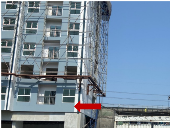
ภาพที่ 29 การติดตั้งผนังสำเร็จของอาคาร
