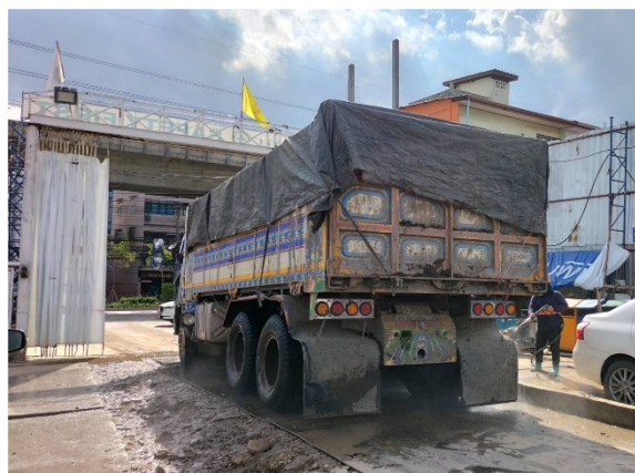
ภาพที่ 17 การปิดคลุมกระบะรถบรรทุก
