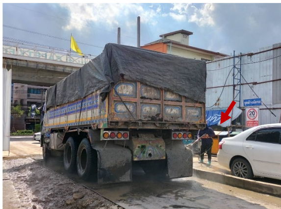
ภาพที่ 15 คนงานคอยฉีดล้างทำความสะอาดล้อรถ
