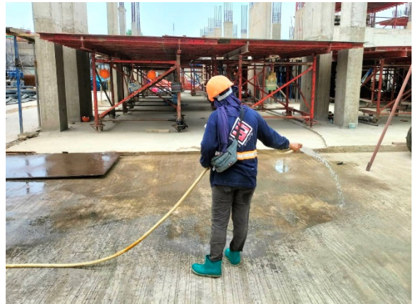
ภาพที่ 10 การฉีดพรมน้ำบริเวณที่ก่อให้เกิดฝุ่น
