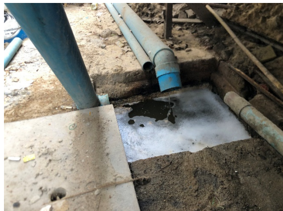
ภาพที่ 49 บ่อรับน้ำจากการก่อสร้างเพื่อตกตะกอน
