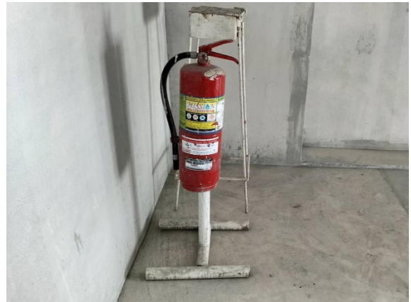
ภาพที่ 54 ติดตั้งถังดับเพลิงตามจุดที่เสี่ยงต่อการเกิดเหตุ
