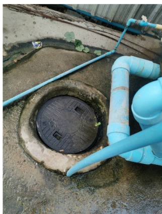
ภาพที่ 36 ถังบำบัดน้ำเสียสำเร็จรูปรองรับน้ำเสียจากห้องน้ำ
